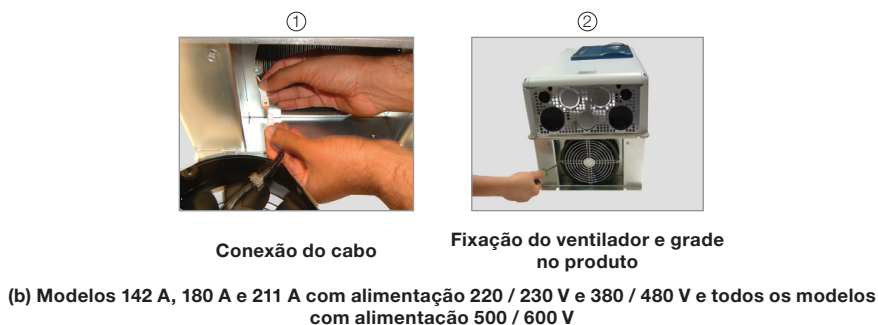
Figura 6.2: (a) e (b) Instalação do ventilador do dissipador
